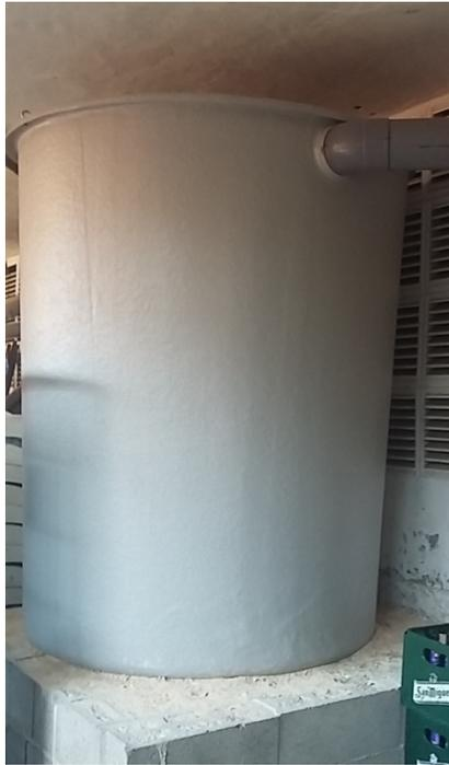
Durante el invierno del 2011-2012 se instaló en el bloque 3 del Aparthotel un pequeño depósito de aguas pluviales que dadas las reducidas precipitaciones existentes en la región durante los meses de temporada no es muy aprovechable, aunque se reutilizan las aguas pluviales captadas para el riego de las plantas interiores del bloque de apartamentos donde está instalado.
